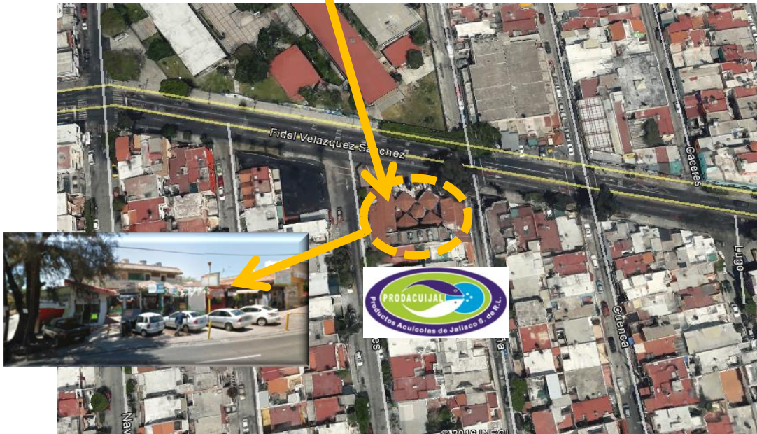
c) Ubicación e instalaciones de PRODACUIJAL dentro de la ZMG
