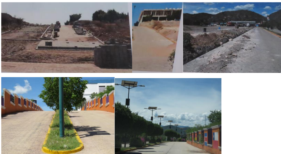
Imagen 9. Obras en construcción y terminadas.
