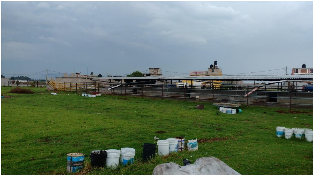
Imagen 25 Parte posterior de las instalaciones
