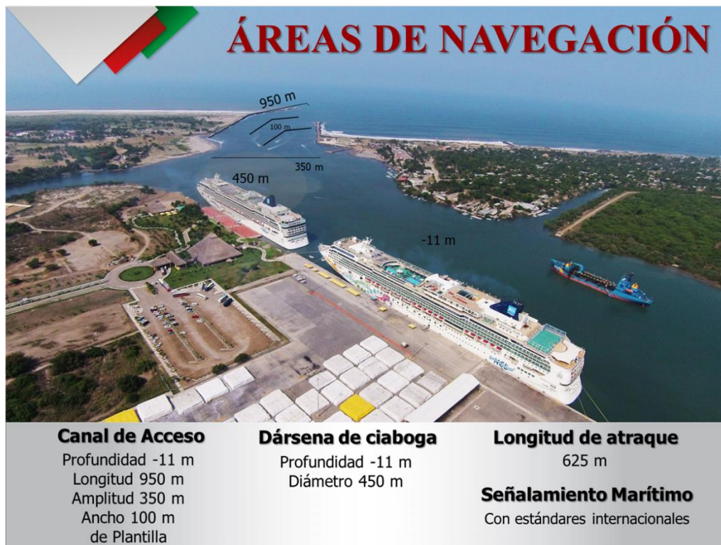
Figura 19. Longitud de la escollera de 950 metros
