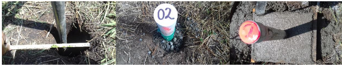
Figura 7a. Perforación manual Figura 7b. Relleno de grava Figura 7c. Brocal de concreto Figura 7. Construcción de pozos de observación
