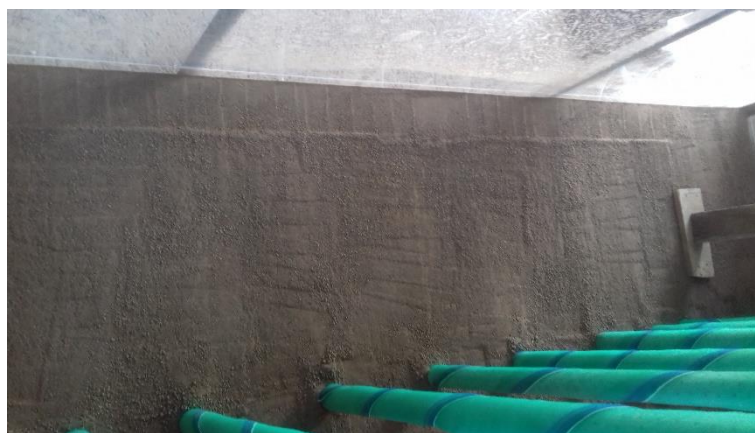
Figura 24. Compactación de suelo
