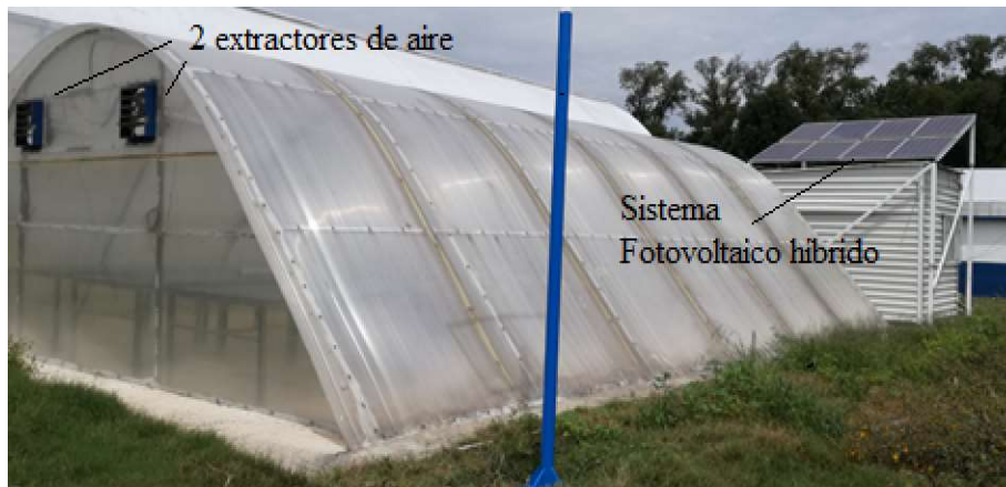
FIGURA 39. INSTALACIÓN COMPLETA DE SISTEMA FOTOVOLTAICO EN SECADOR SOLAR.
