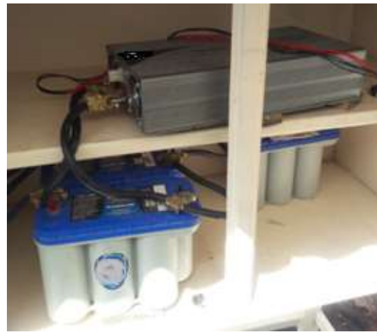
FIGURA 33. INSTALACIÓN DE LOS PANELES FOTOVOLTAICOS Y CONEXIÓN DE INVERSOR Y BATERÍAS EN GABINETE ELÉCTRICO.
