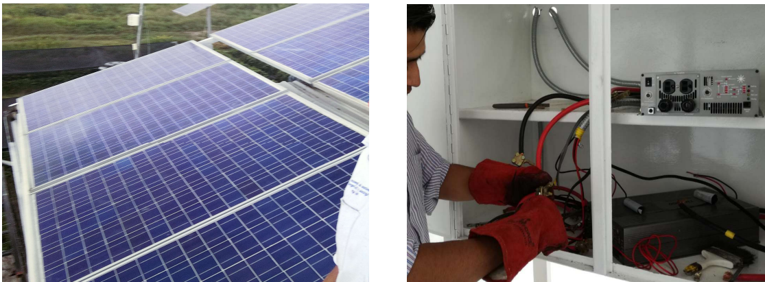
FIGURA 38. INSTALACIÓN DE PANELES Y CONEXIÓN ELÉCTRICA DE INVERSORES.
