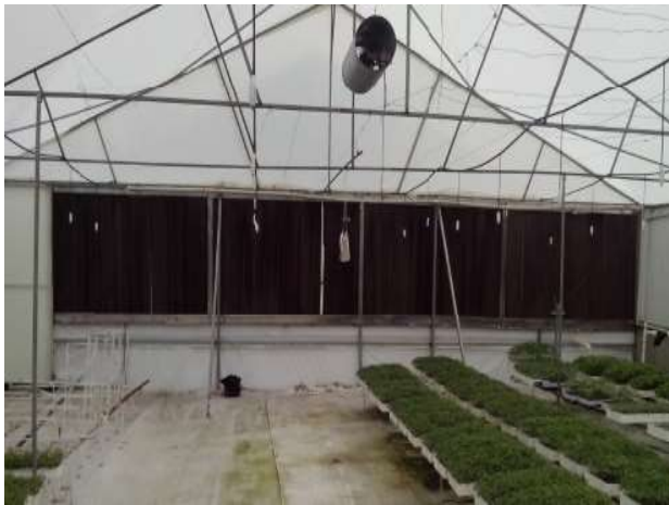
FIGURA 12. PARED HÚMEDA. (IZQUIERDA) Y EXTRACTOR DE AIRE (DERECHA).
