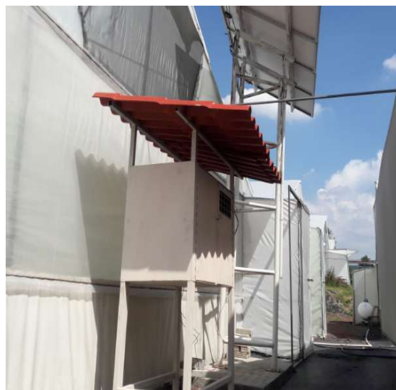
FIGURA 34. INSTALACIÓN FOTOVOLTAICA CONCLUIDA.
