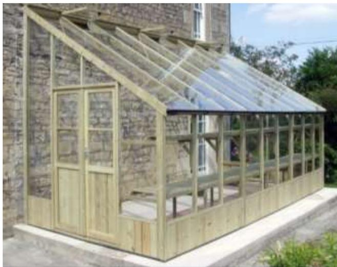
Figura 15 Invernadero tipo única caída a base de madera y cristal. Fuente: Tigerdoor 2021.
