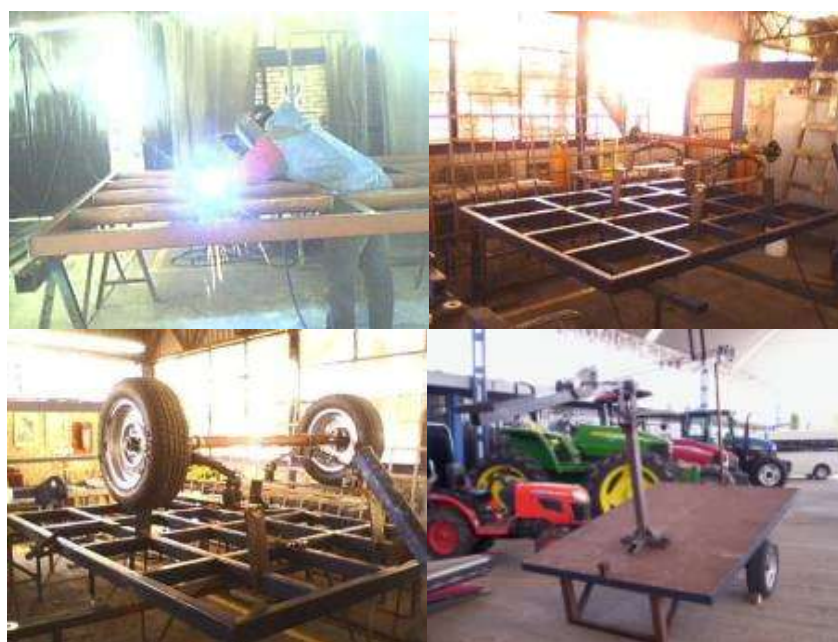
Figura 46. Construcción de la plataforma.
