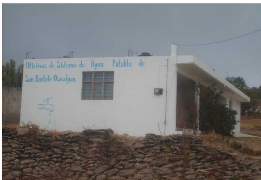
Imagen 8. Oficinas del Sistema de Agua Potable de San Bartolo.
