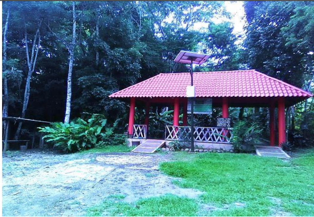
Imagen 6. Caseta de cobro y estacionamiento
