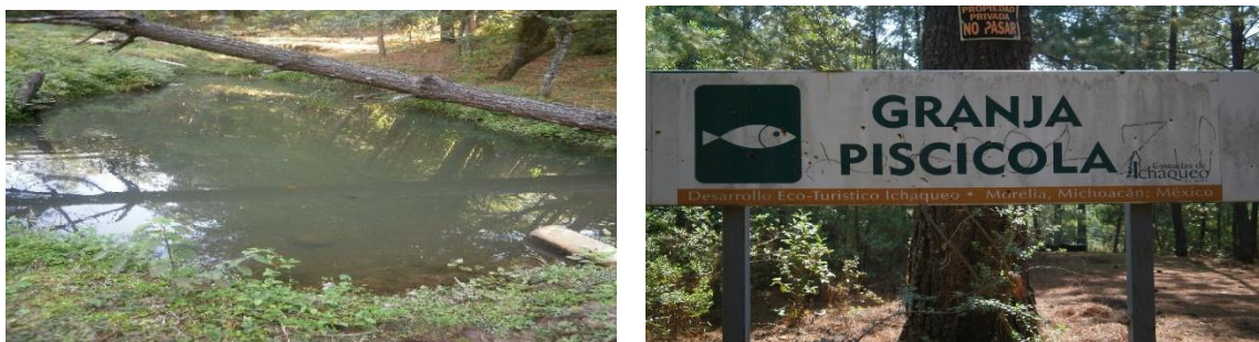
Figura 47. Granjas de trucha inactivas con estanques de tierra y concreto en el municipio de Morelia.
