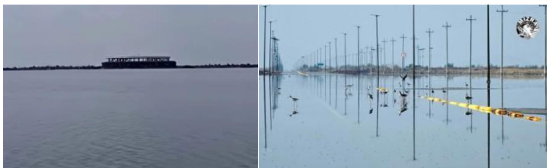
Figura 2- Torre de control y caminos del AICM inundados
