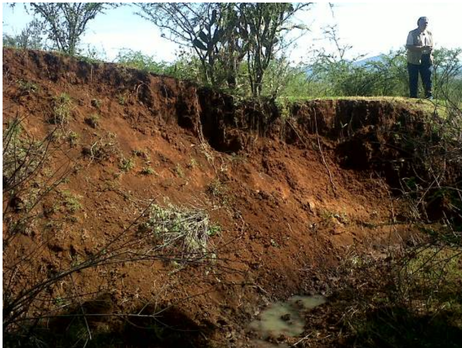
Figura 15 Cárcavas en zona de agostadero 2
