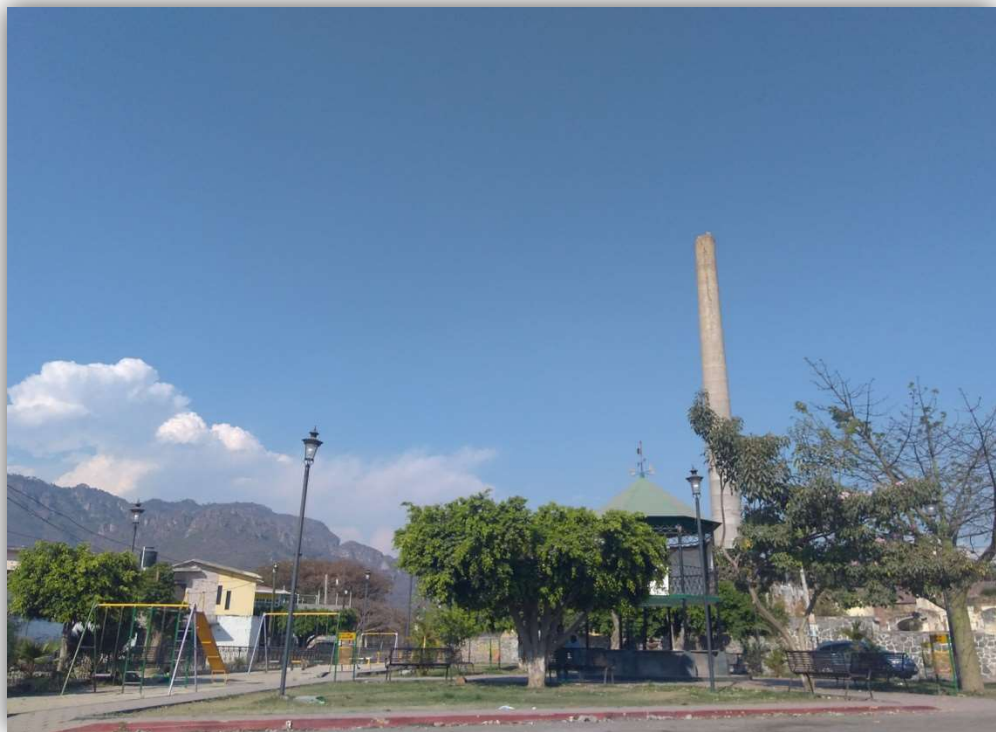
Imagen 32. Plazuela y parque rehabilitados. Al fondo, uno de los chacuacos del ex ingenio.
