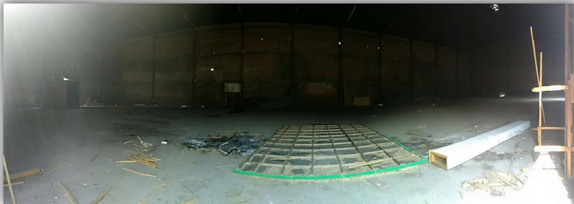
Imagen 12. Bodega de almacenamiento de azúcar.
