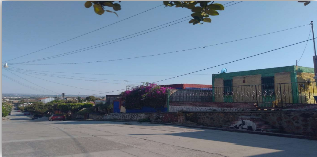
Imagen 15. La casa amarilla a la derecha es el prototipo de vivienda entregado por el sindicato a los obreros; posteriormente, algunos añadieron un portón o modificaron la fachada. Al fondo se aprecia el valle de Oacalco.
