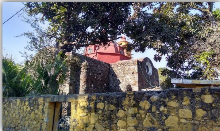
Imagen 34. Al fondo, se pueden observar tablillas de madera en los trabajos de restauración del campanario de la parroquia del siglo XIX.
