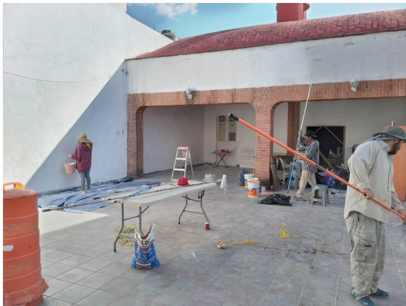
Figura 50. Faena de trabajo para reparar y pintar las paredes del salón donde se ubica la Casa del Gran Corazón. Fuente: Juan Flores, archivo personal.
