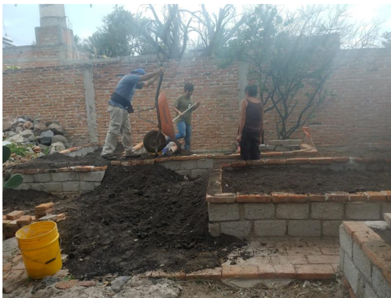
Figura 43. Proceso de construcción del huerto comunitario. Fuente: archivo personal.
