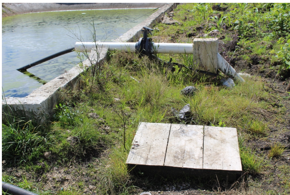
Fotografía 12. Estanque, llave de salida y pocito
