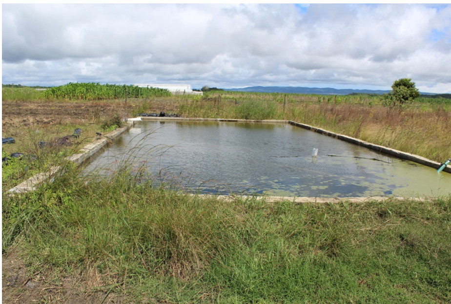
Fotografía 9. Estanque de almacenamiento
