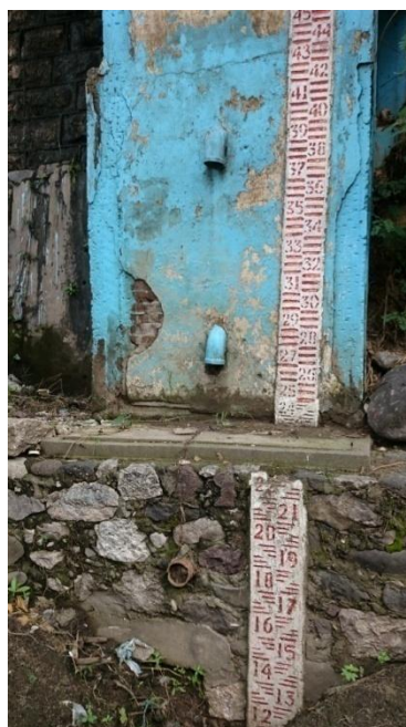
Figura 20. Limnómetro de la estación hidrométrica.
