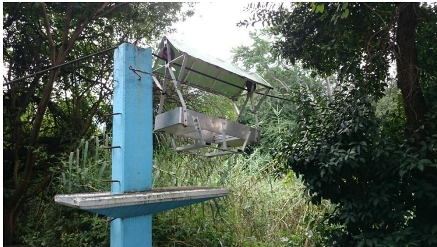
Figura 19. Sistema de cable vía y canastilla de la estación hidrométrica.
