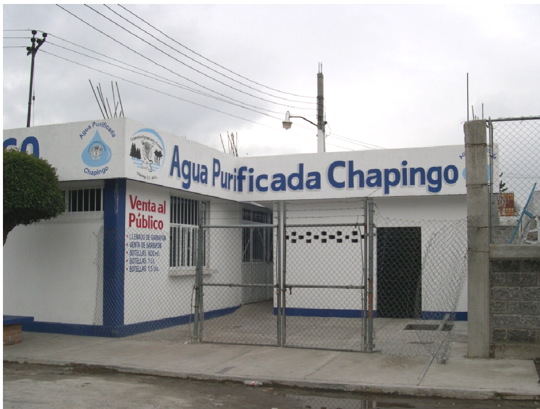
Figura 4. Planta de Agua Purificada Chapingo (objeto de la experimentación).
