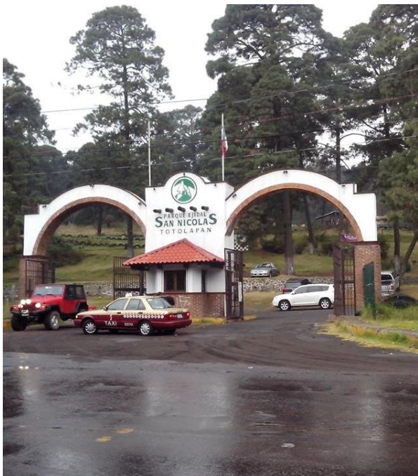
Figura 54. Entrada al parque ejidal
