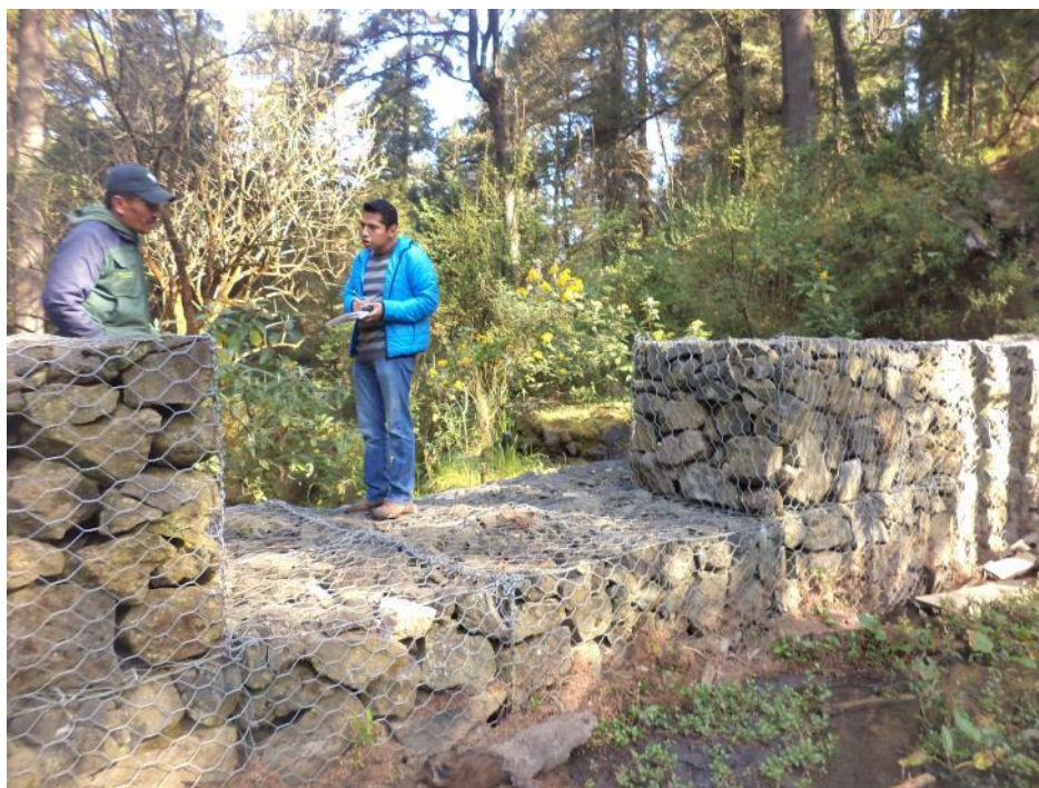
Figura 62. Presa de gavión.
