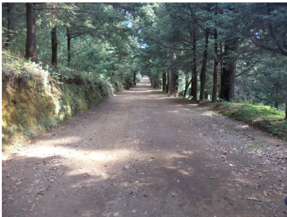
Figura 63. Rehabilitación de caminos.
