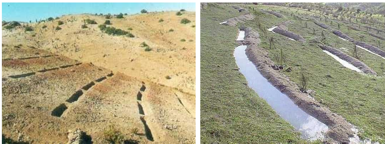
Figura 14. Zanjas trincheras con reforestación
