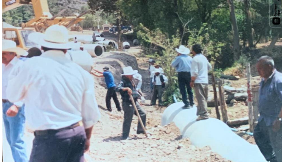
FAENA PARA EL DRENAJE DE LA CALLE 1
