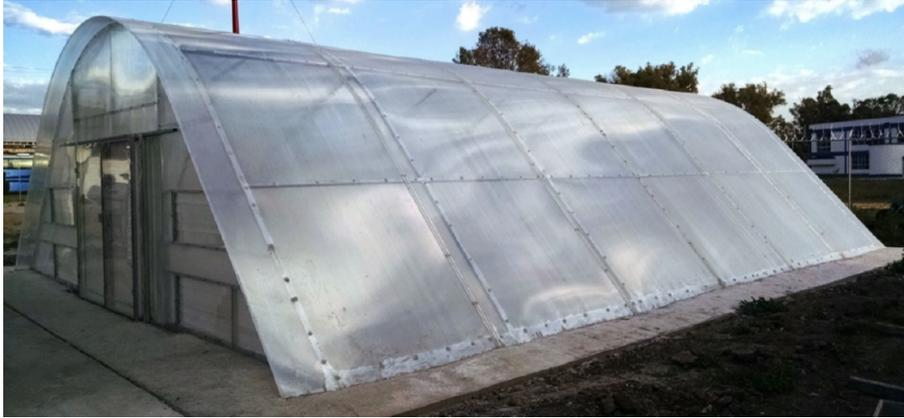
Figura 3.1: Sistema secador solar tipo invernadero de forma parabólica y cubierta de policarbonato ubicado en Chapingo, México.
