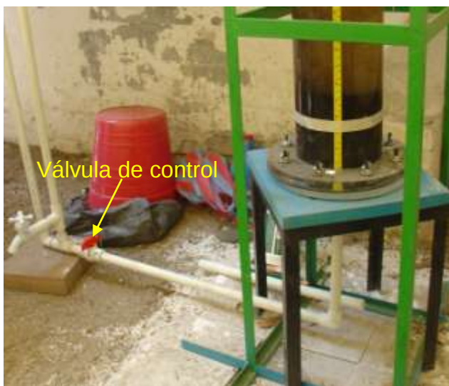
Figura 8.7a Válvula de control de flujo de agua residual.
