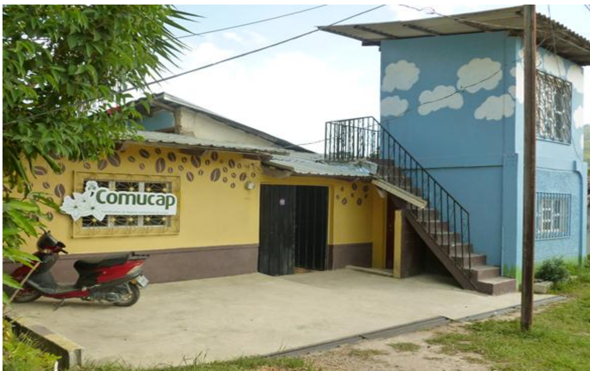
Anexo 1. Instalaciones de COMUCAP, ubicadas en Marcala.
