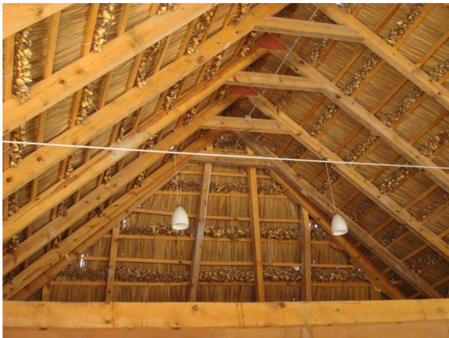
Figura 28. D. longissimum empleado para techar una cabaña rústica.
