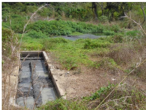
Imagen 7. Planta de tratamiento de aguas negras de la CRS Jaltenango La Paz, (2015).
