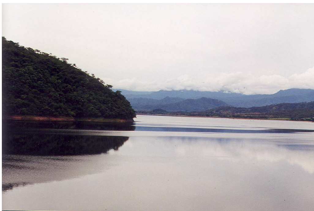
Desde el embalse de la Presa de almacenamiento El Portillo II
