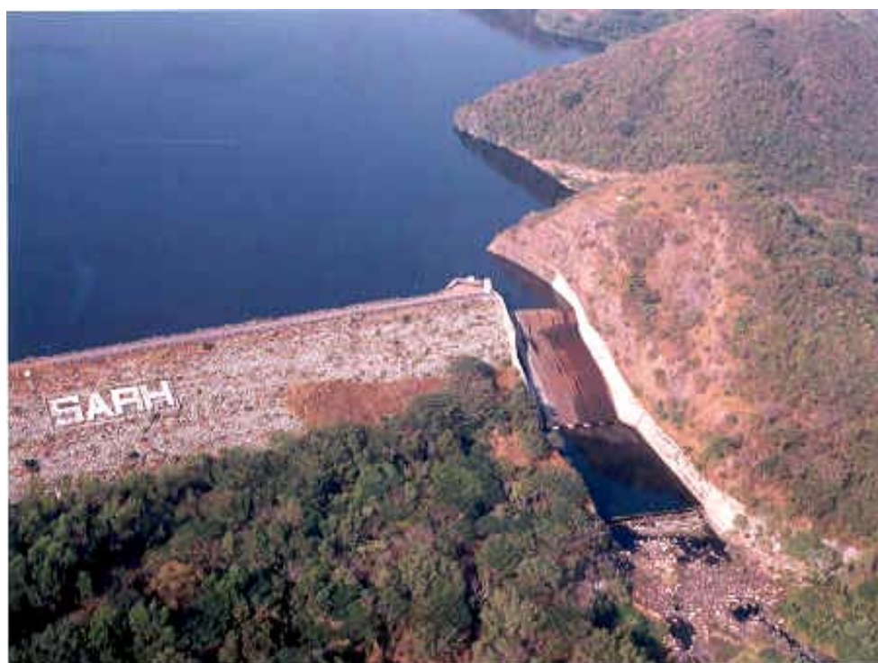
Figura 5.37 Vista aérea de la Presa Juan Sabines Gutiérrez (El Portillo II), Chiapas
