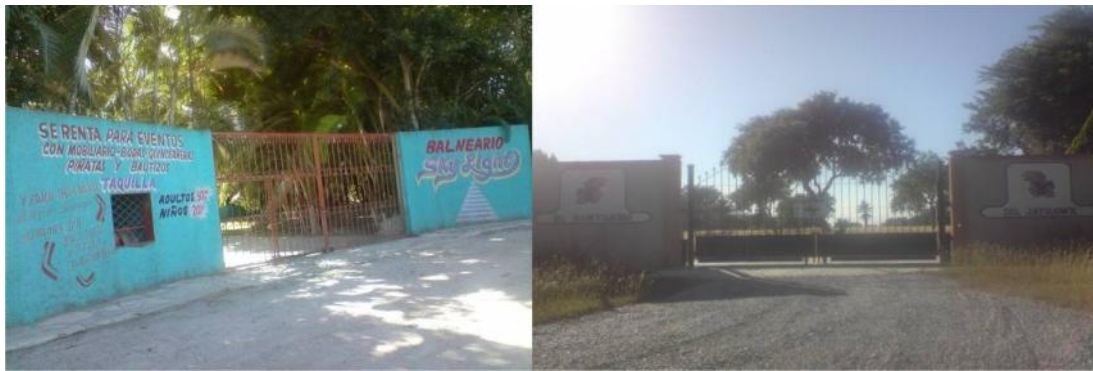
Figura10. Balnearios en el Municipio de González, a la izquierda en San Antonio Nogalar, a la derecha en la Presa Emilio Portes Gil
