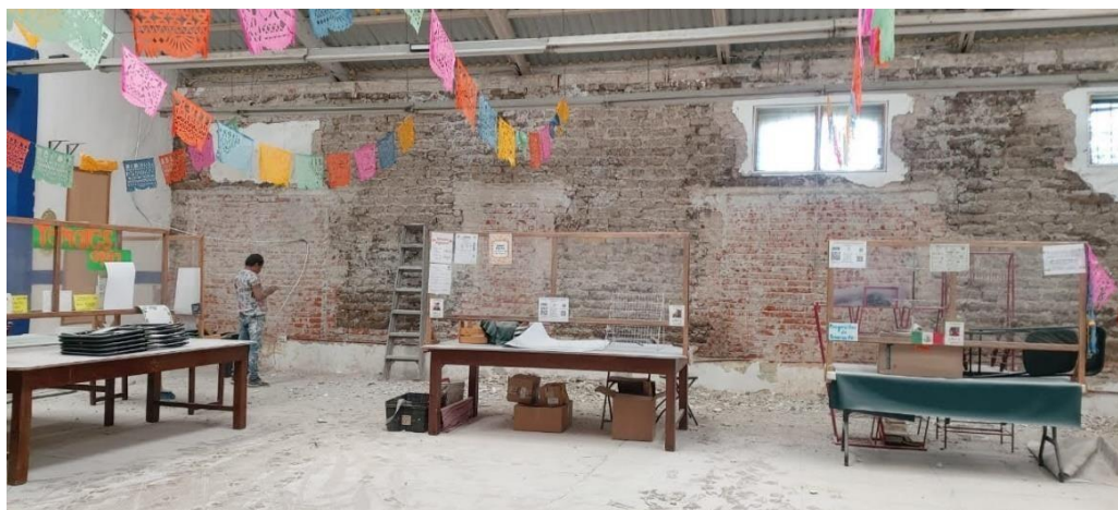
Foto 7: Reparación del muro principal por iniciativa de los operadores activos del TOCh.
