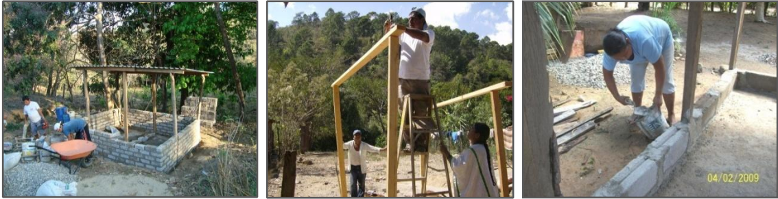
Construcción de infraestructura
