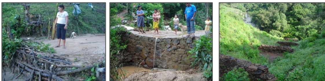
Obras de conservación de suelos. Los muros de piedra acomodada han detenido la erosión en cárcavas
