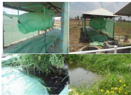
Figura 8. Biodigestor de flujo continuo (parte superior) y fosa de efluentes (parte inferior)
