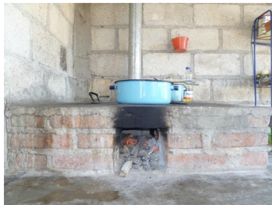
Figura 4. Vista general de la estufa Lorena construida en las dos comunidades.
