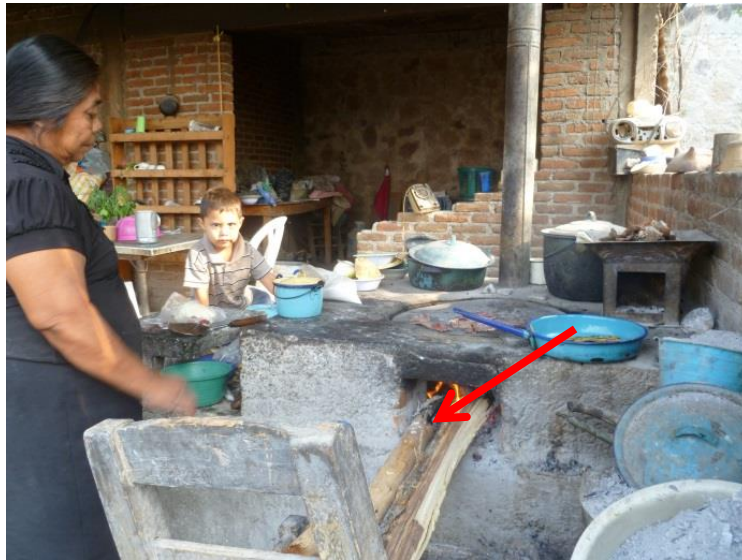
Figura 8. Ausencia de la base que sostiene los leños.
