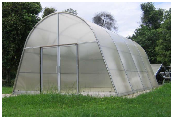
Figura 2-6. Secador solar tipo invernadero de forma parabólica con cubierta de policarbonato y piso de concreto (Janjai et al. , 2009).
