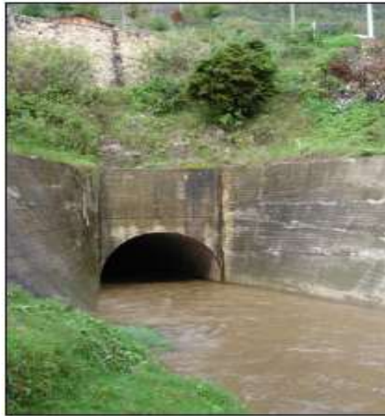
Figura 3. Túnel que drena el agua de la cuenca de San Cristóbal de las Casas hacia el río Grijalva.
