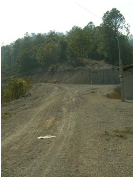
Figura 24. Caminos intransitables en época de lluvia.
