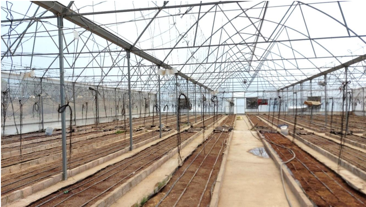
Figura 5. Invernadero tipo cenital de estructura metálica con cubierta de polietileno térmico y alta dispersión de luz en donde se llevó a cabo la fase de producción.
