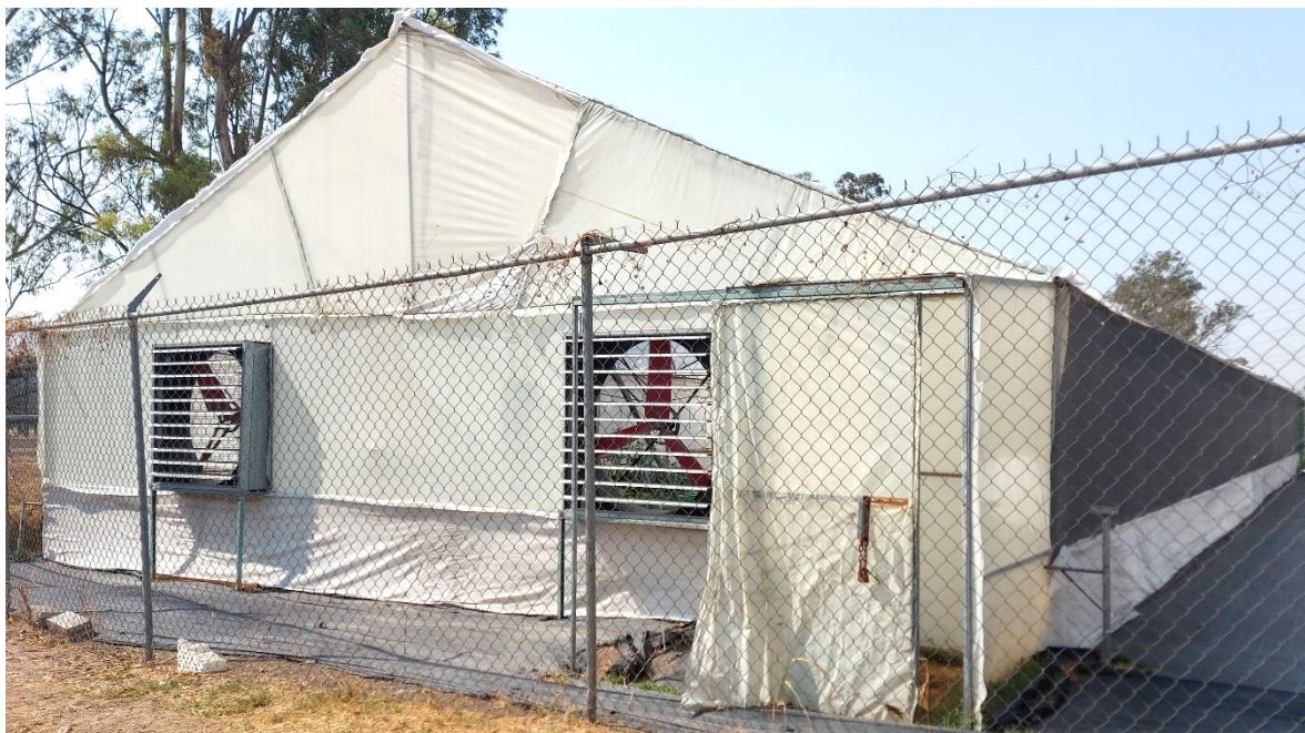
Figura 1. Invernadero tipo capilla de estructura metálica con cubierta de polietileno en donde se llevó a cabo la fase de semillero del experimento.
