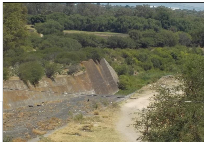
Canal de desazolve de la presa.
