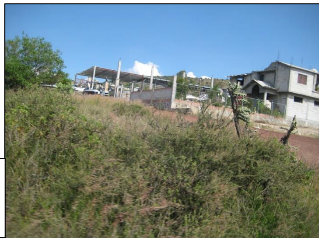
Construcción de viviendas en zona de pendiente.
