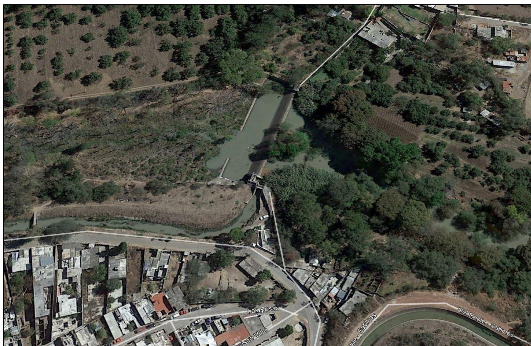
Figura 26. Canal derivador Lomo de Toro, actualmente contaminado
