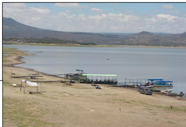
El agua residual de comercios y viviendas se mezcla con la represada.
