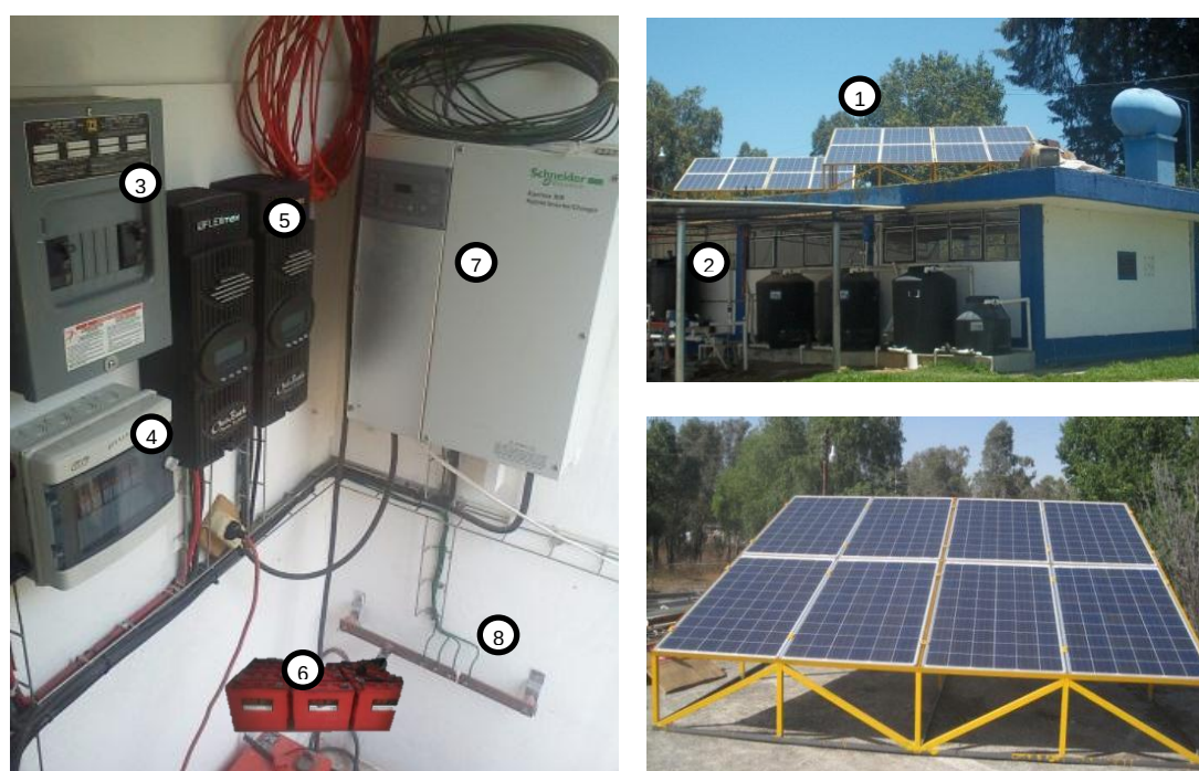
Figura 43. Componentes del sistema fotovoltaico
