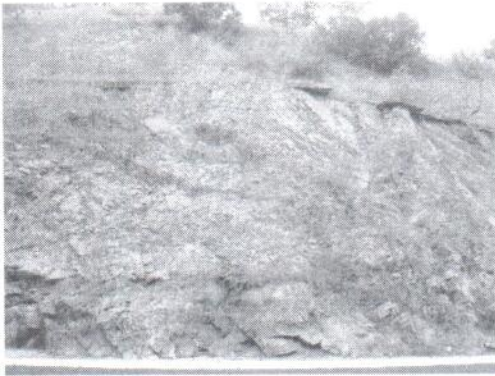
Vista general del talud en el sitio 5
