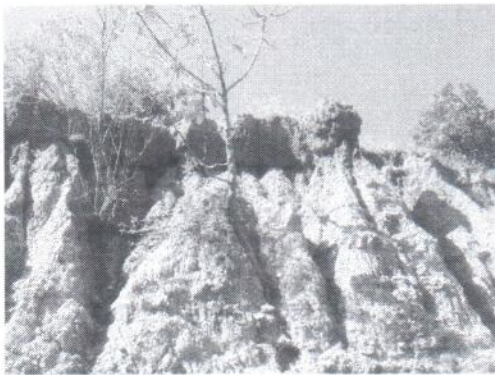
Erosión en las partes altas del talud
