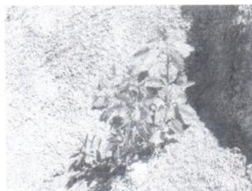
Cobertura de malla y cemento
