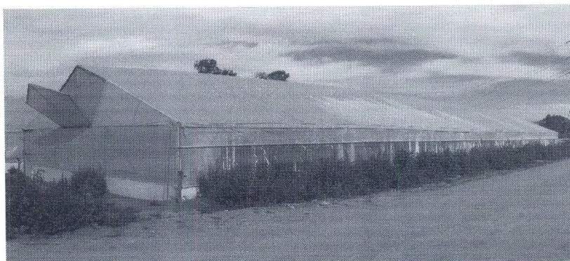
Figura 1A. Invernadero tipo capilla simétrico.
