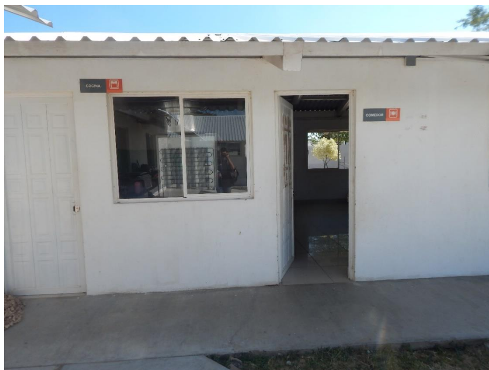
Foto 15. Instalaciones del albergue, Arriaga, Chiapas
