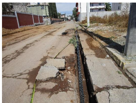
Ilustración 31 Instalación de la red de agua potable
