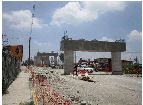
Ilustración 5 Foto Puente vehicular en construcción
