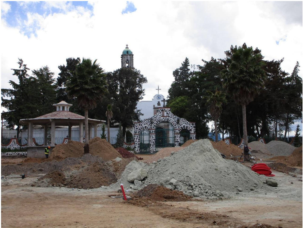
Ilustración 35 Foto de la plaza en construcción de San Miguel Xaltocan, Nextlalpan
