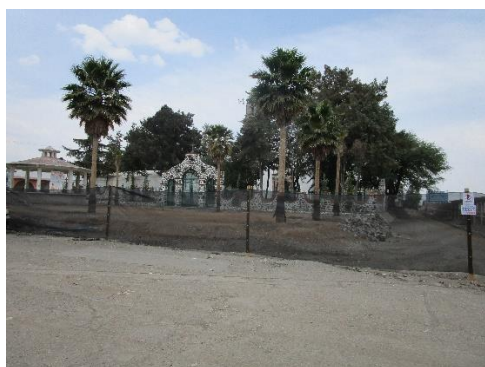
Ilustración 33 Foto de la reconstrucción de la plaza
