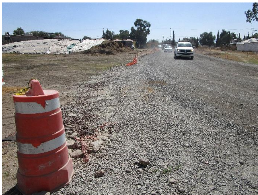
Ilustración 14 Foto de vía provisional
