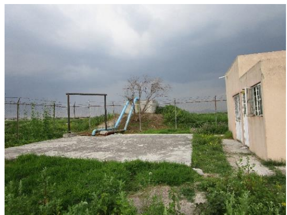
Ilustración 30 Foto de la poza de oxidación
