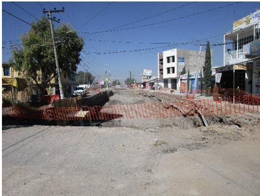
Ilustración 4 Foto de excavación
