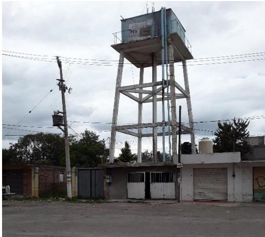
Ilustración 27 Foto del tanque elevado en San Miguel Xaltocan
