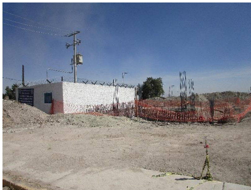
Ilustración 29 Foto de la construcción del tanque elevado
