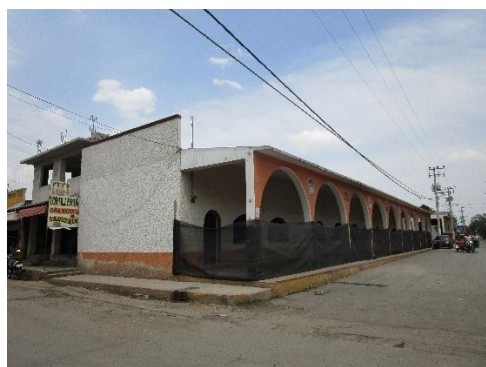
Ilustración 34 Foto de la demolición del museo
