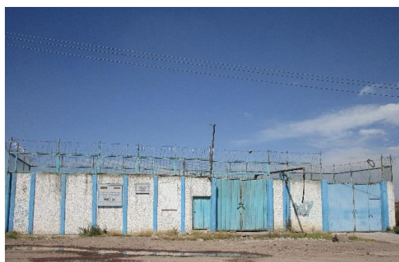
Ilustración 18 Foto de las Instalaciones Pozo 34
