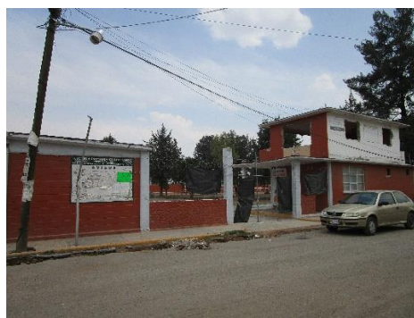
Ilustración 32 Demolición de la primaria
