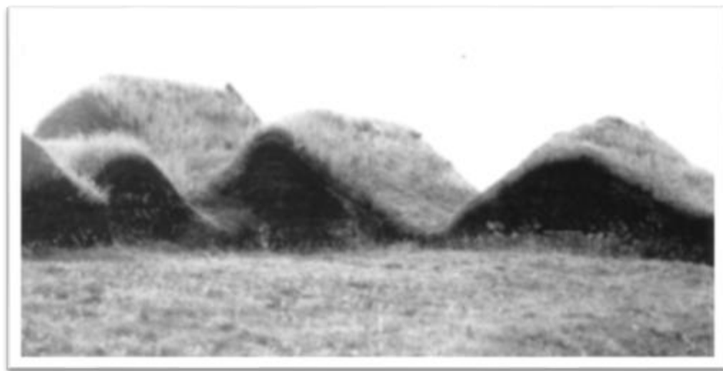
Figura 8. Casas tradicionales de panes de césped en Islandia (Minke, 1982).
