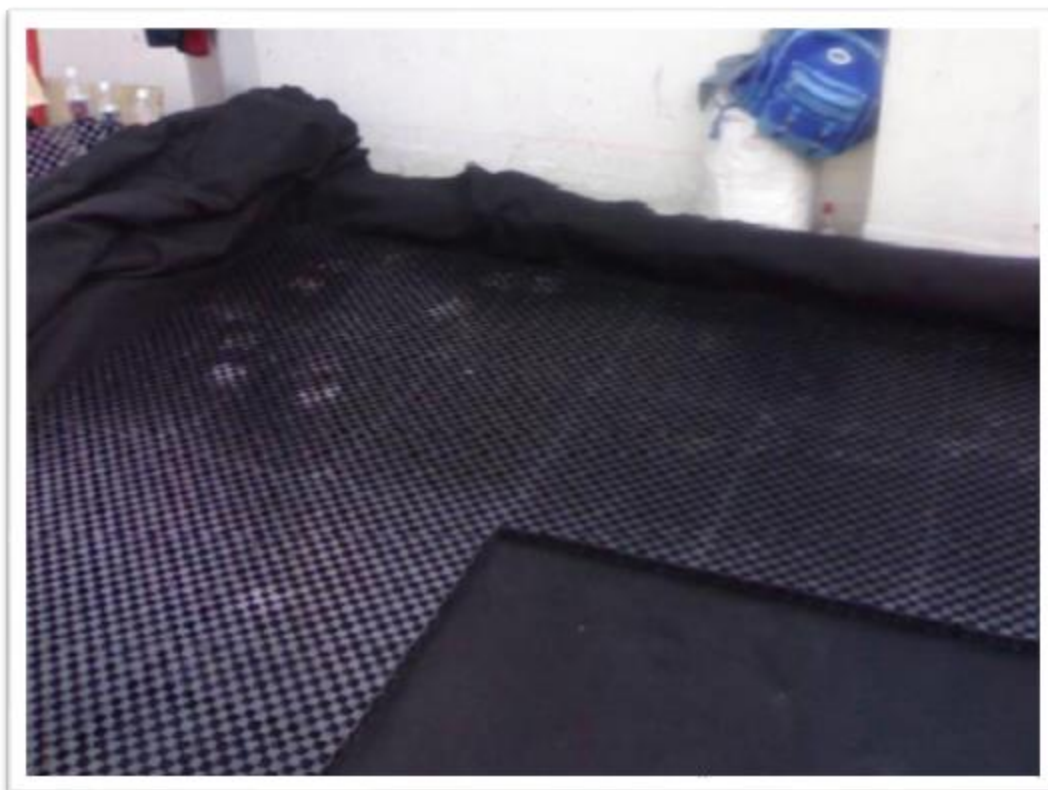
Figura 19. Vista a detalle de las capas del sistema Atlantis (Atlantis, 2011).
