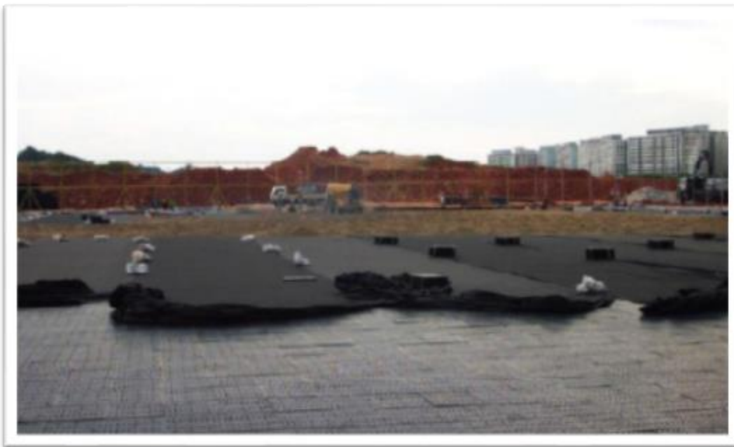
Figura 18. Aplicación de capas de sistema Atlantis (Atlantis, 2011).
