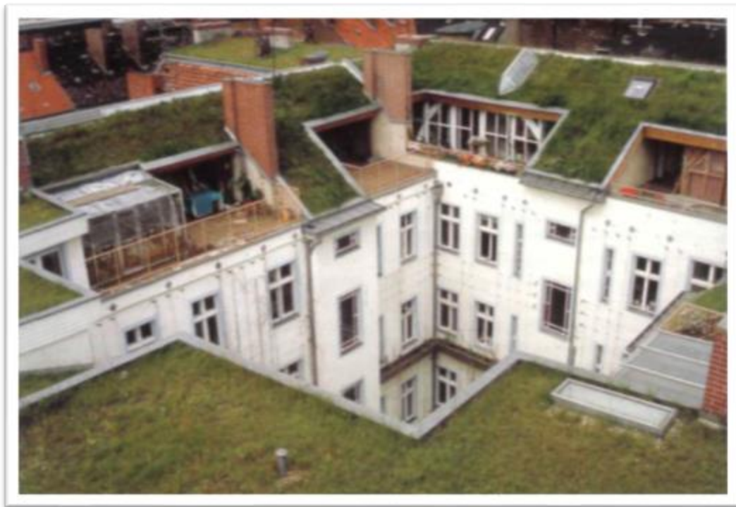
Figura 12. Ampliación sobre azotea con techos de césped, Berlín-Kreuzberg (Alemania)
