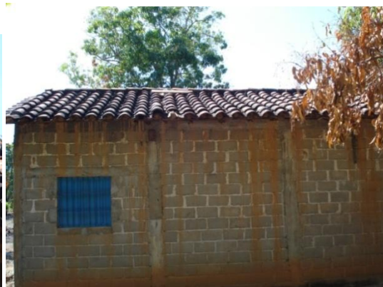
d. Vista exterior de la bodega
