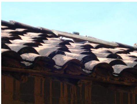
c. Vista exterior de techo
