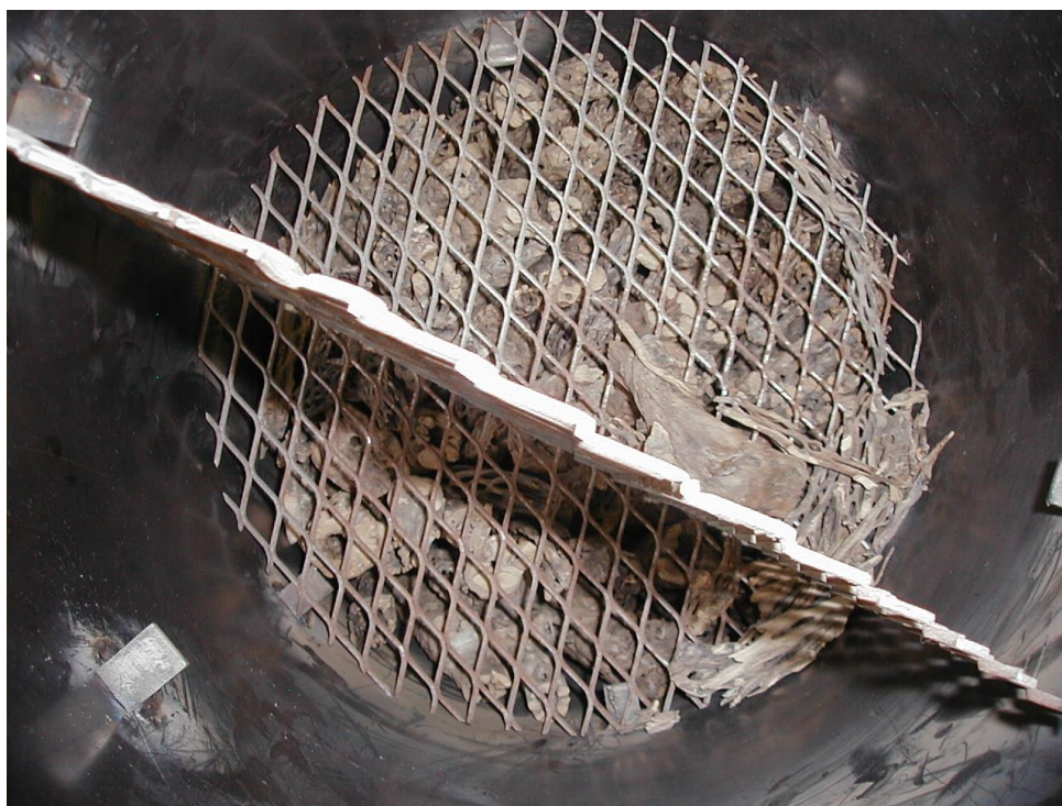
Anexo4. Colocación del soporte dentro del bioreactor.
