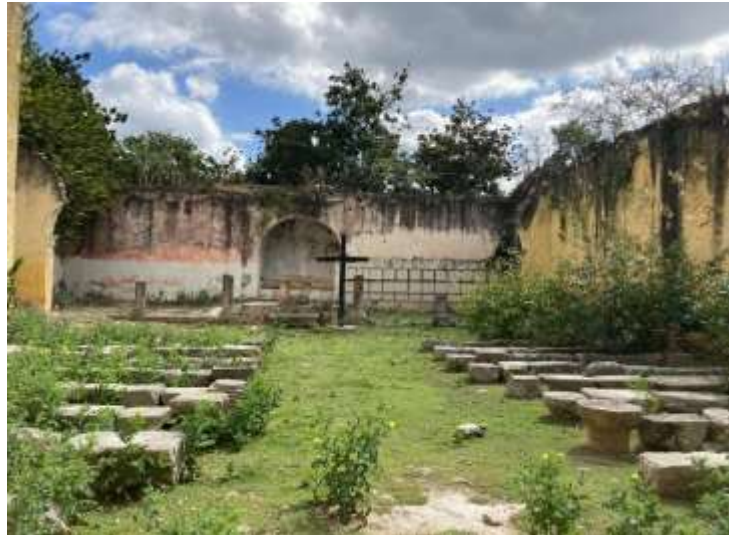
Figura 5. Iglesia derruida en Tihosuco. Archivo del autor, 2024.
