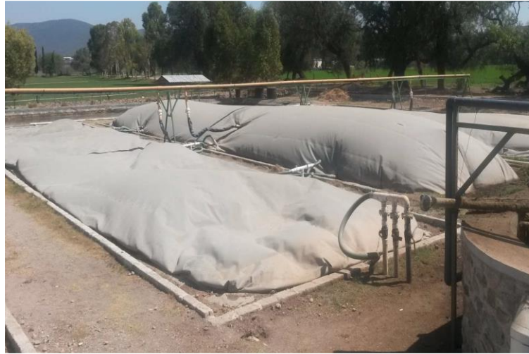
Figura 5. Reactores anaeróbicos de laguna cubierta en el Rancho la Hondonada, Querétaro, México.
