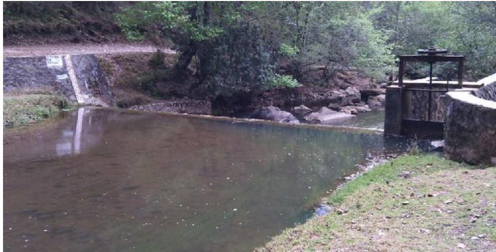
Figura 2. Presa derivadora de la unidad de riego San Nicolás
