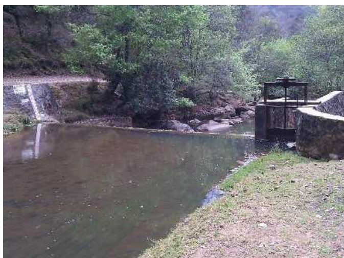
Figura 14. Presa derivadora de la unidad de riego
