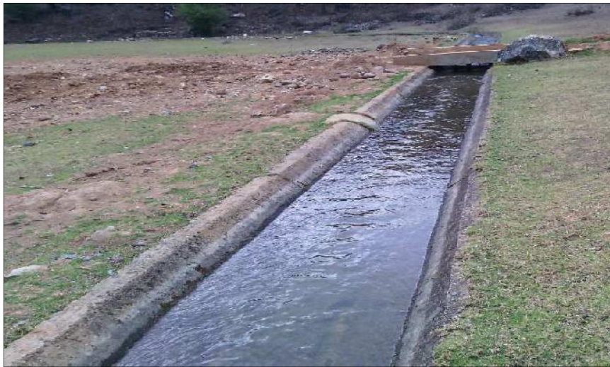
Figura 3. Canal de conducción
