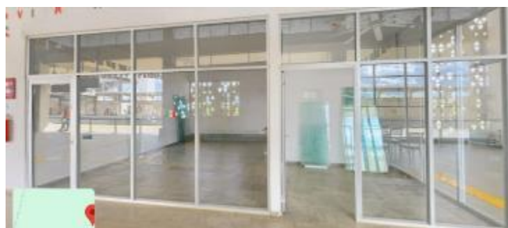
Figura 14: Establecimientos dentro de la estación
