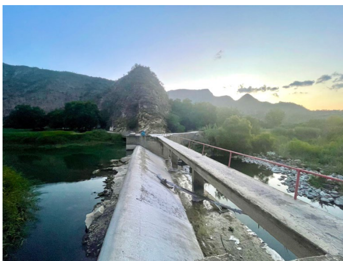
Imagen 4: Presa derivadora “Apanco”, DR 08 Metztitlán, Metztitlán, Hgo. Levantamiento de imagen, Ángeles-Palafox Francisco A., 5 de agosto 2022.
