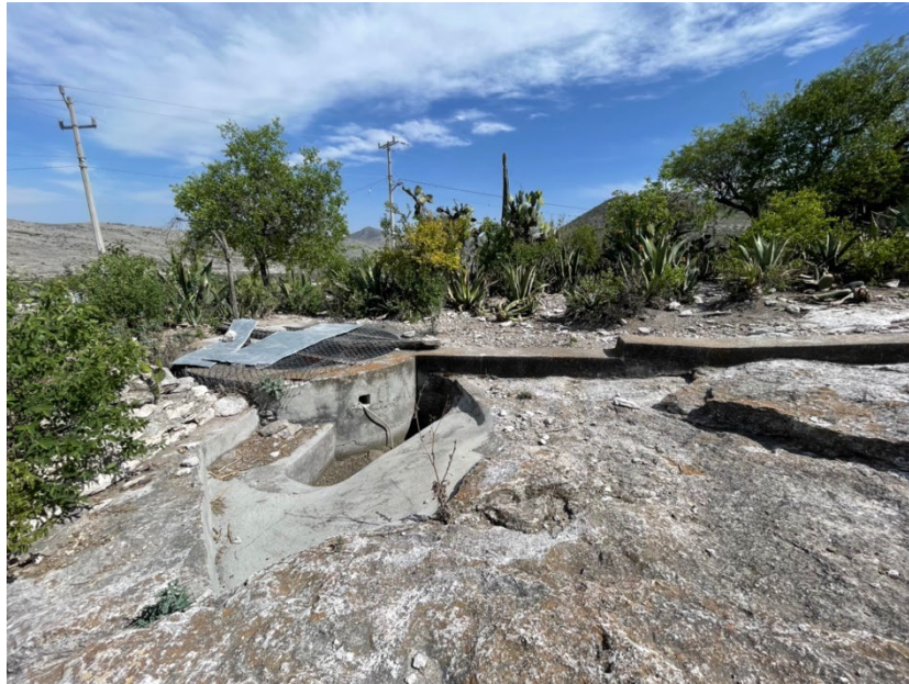
Obra para cosecha y almacenamiento de agua de lluvia, Itztazacuala, Metztitlán, Hidalgo Levantamiento de imagen, Ángeles-Palafox Francisco A., 25 de abril 2023
